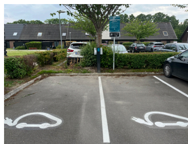
To laderpladser i øst
